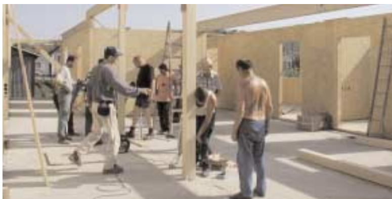
Was hier noch im Rohbau steht, soll im April 2004 bezugsfertig sein: Arbeiten am Ärztehaus in Reps/Siebenbürgen. Foto: Blome
